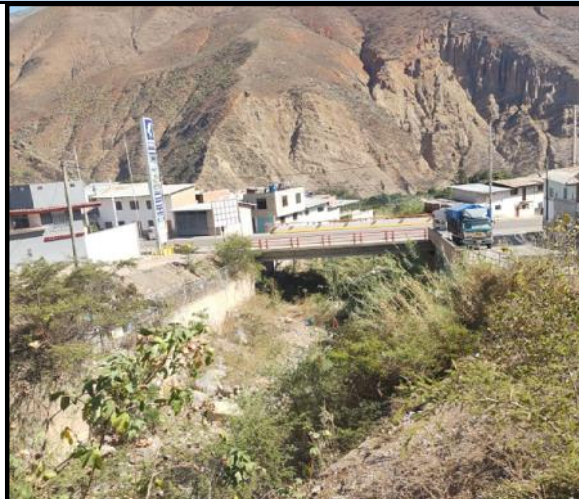
FIGURA N°02: ESTRUCTURA PUENTE QUE SE ENCUENTRA COLMATADO
